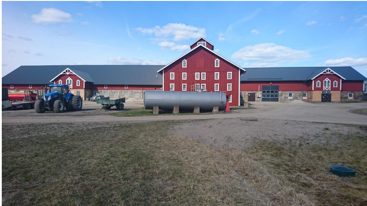
Tork och verkstadsbyggnad m.m. på Henriksbergs gård
